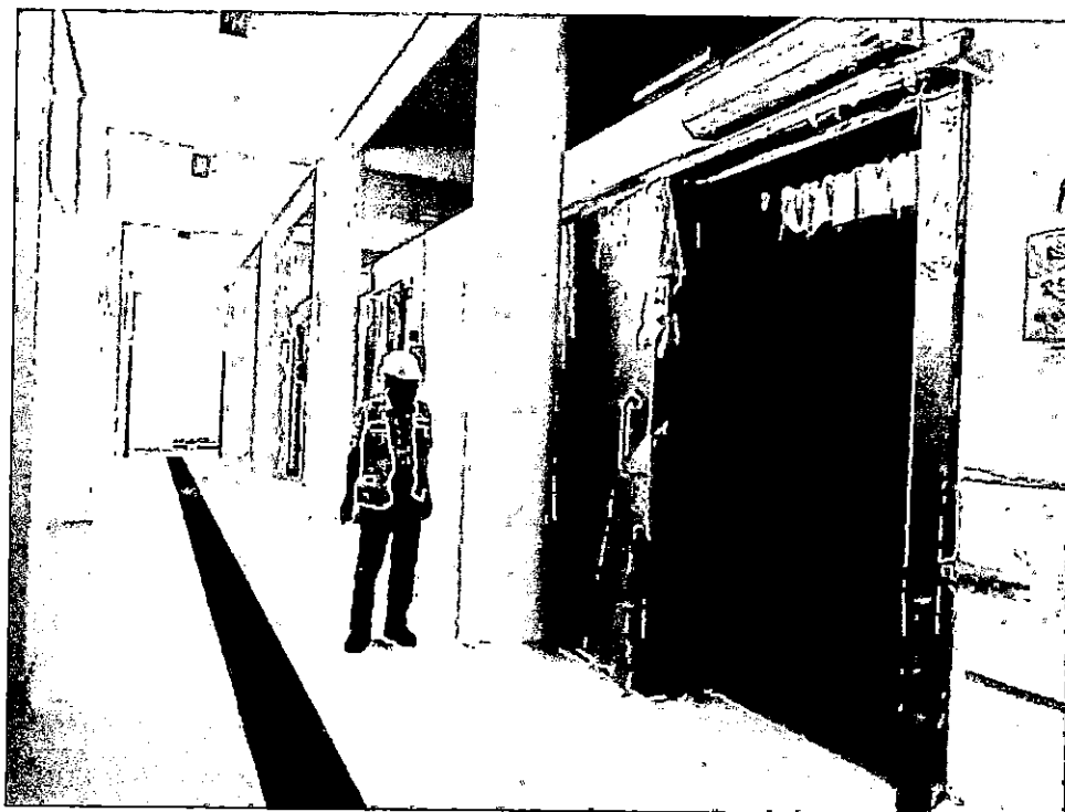
VISTA DE LAS CAMARAS FRIGORIFICAS Y DE CONSERVACION DE HIELO
