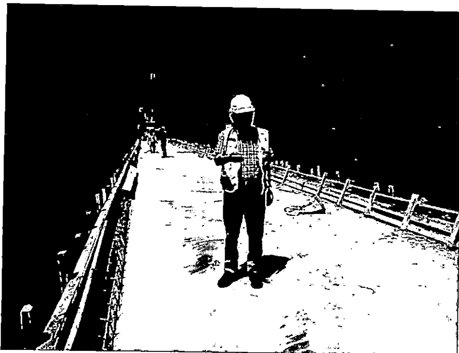
SUPERVISOR EN LOSA DEL MUELLE EJE- 163-164
