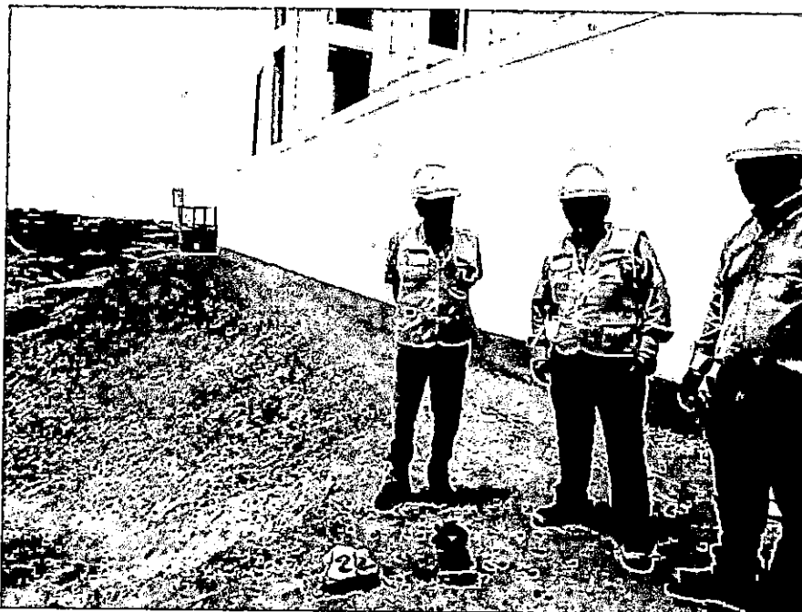
COLOCACION DE HITOS DE REFERENCIA DE LOS PUNTOS INDICADOS EN PLANOS
