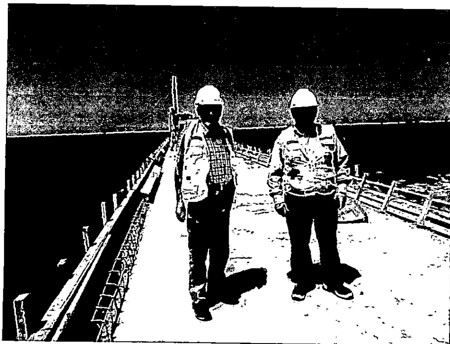
SUPERVISOR Y NUEVO RESIDENTE VERIFICANDO TRABAJOS EN SARDINEL DEL MUELLE
