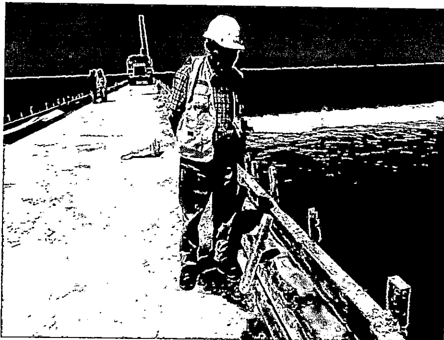
SUPERVISOR VERIFICANDO TRABAJOS
